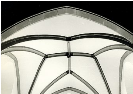
Gotisches Rippengewölbe im Chor von ca. 1520 und neugotischer Chorbogen vom 1888: Quelle: Denkmalpflege Zürich – Mönch- altorfer Forum.
