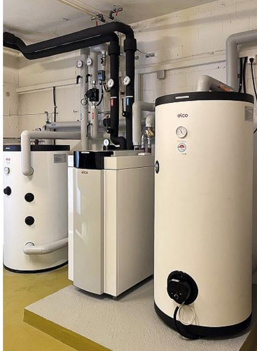
Eine Sole-Wasser-Wärmepumpe. Fotos: zvg.
