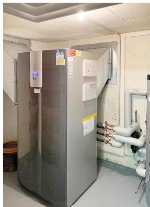
Zu sehen: Eine Luft-Wasser-Wärmepumpe Innen.
