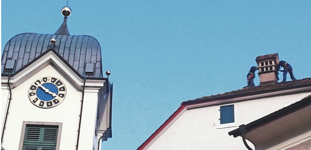
Am Kamin auf dem Schlossdach wurden Schutzgitter angebracht, damit die Dohlen nicht mehr im Kamin nisten können.
